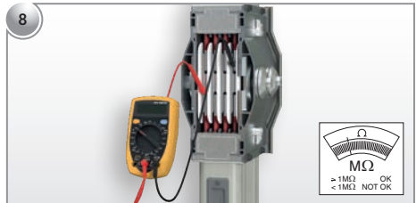
Montajlanan ek noktasında tüm fazlar arasında izolasyon direnç testi uygulanmalıdır.
